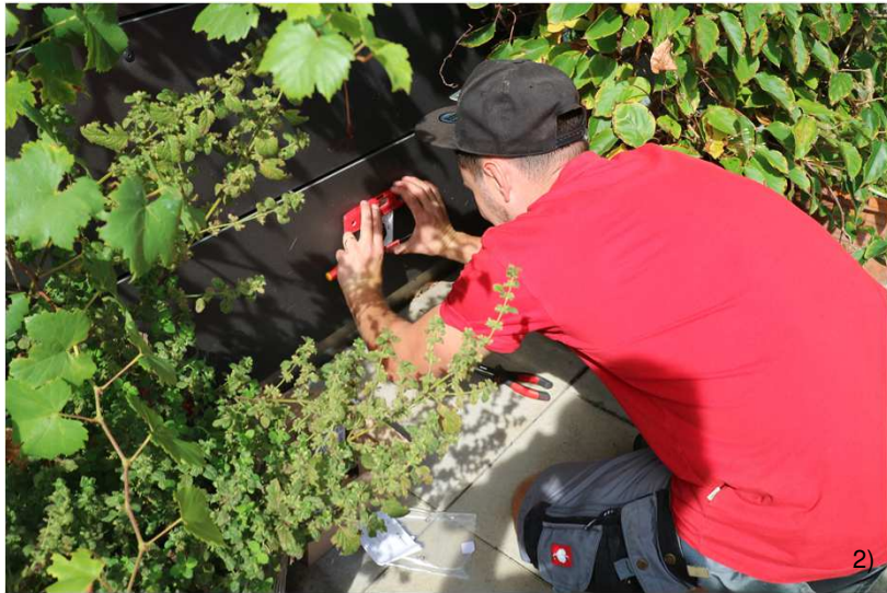
Elektriker beim Tauschen der Steckdose
