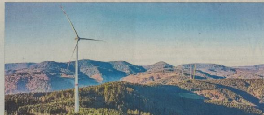
Auf dem Hohenlochen wird zur Zeit ein Windpark errichtet. Vier Windräder sollen dort Energie gewinnen. Archivfoto: Andreas Walny
